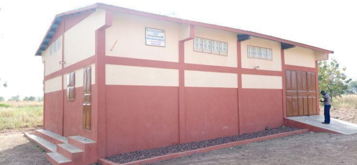
Magasin de stockage construit par FI-Agri/Cobly
